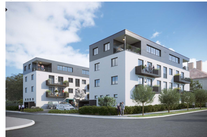
POHLED NA OBJEKT
