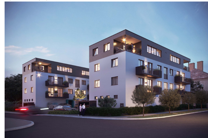
POHLED NA OBJEKT
