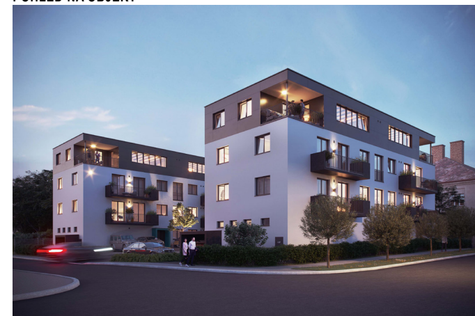
POHLED NA OBJEKT
