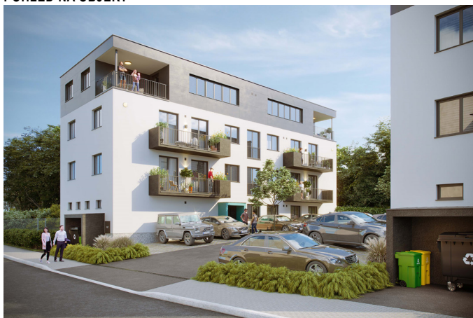
POHLED NA OBJEKT
