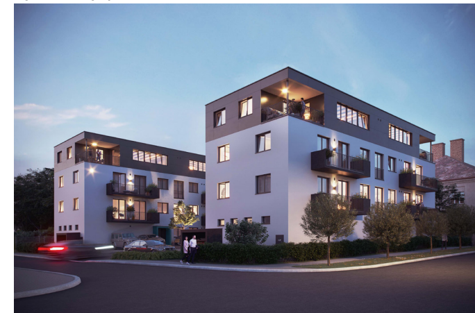
POHLED NA OBJEKT
