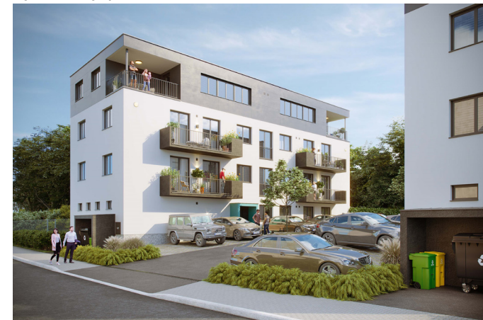
POHLED NA OBJEKT
